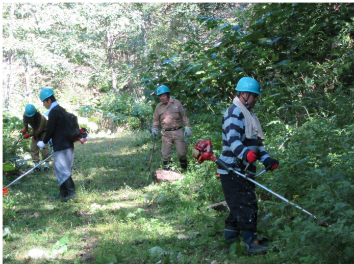
安全を確保し指示された幅員3mに仕上げている 笹の葉が生い茂り苦難したが2.7kmを作業を実施
